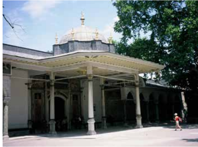
Abb. 19: Istanbul, Topkapı Sarayı, Tor der Glückseligkeit (Bâbüssaade). Foto Christian Ottersbach
