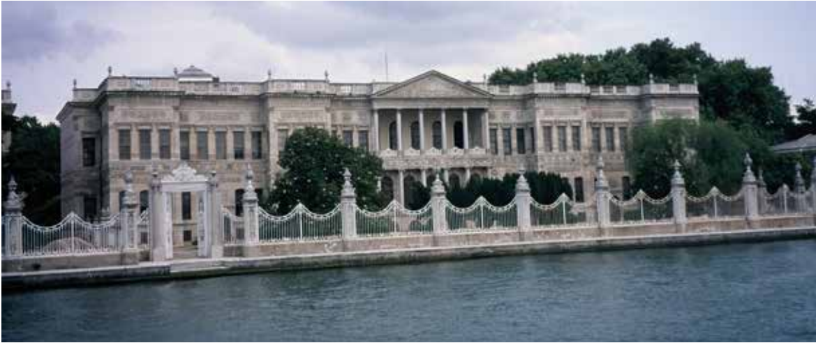
Abb. 6: Istanbul, Dolmabahçe Sarayı, der Trakt für den Kronprinzen vom Bosphorus aus gesehen. Foto Christian Ottersbach
