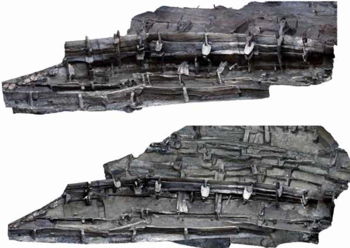
Abb. 8 Die obere und untere Bohlenwandstufe der neuen Wallinnenfront (etwa 965), Foto Christian Hartl-Reiter
