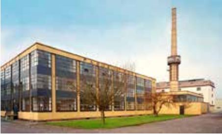
Abb 9 Das Fagus-Werk in Alfeld (Rückseite), Deutschland, Quelle: https://commons.wikimedia.org/wiki/File%3AFagus_Gropius_Hauptgebäude_200705_wiki_rueckseite.jpg , Carsten Janssen / cc-by-sa-2.0-de [CC BY-SA 2.0 de]
