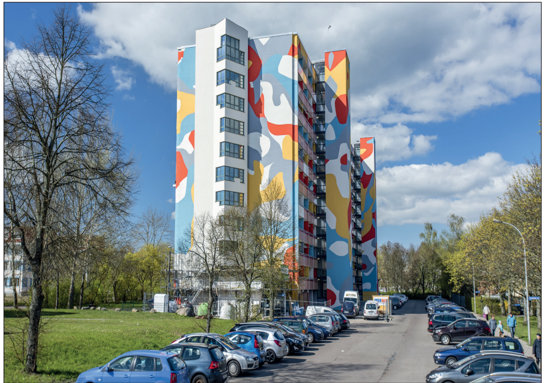
Gerade hat die WGS das Hochhaus in der Rahlstedter Straße umfassend saniert.
