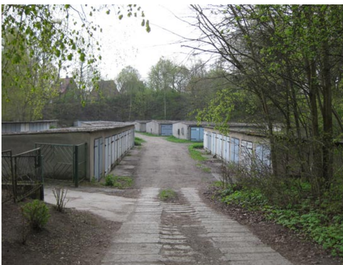
Der südliche Bereich des Grundstückes ist mit Reihengaragen bebaut.
