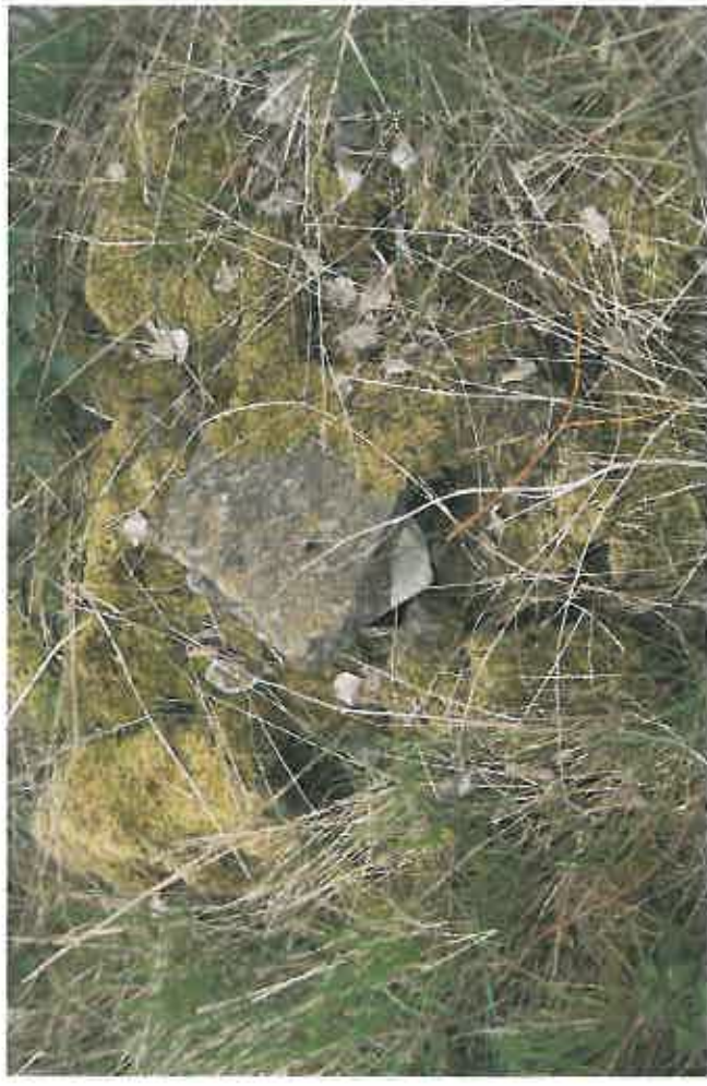
Foto 4: Fläche C: Bauschuttalagerungen
