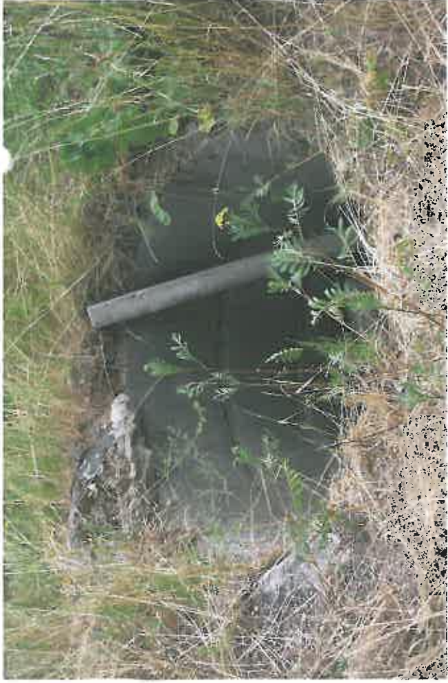
Foto 17: Fläche C: Schacht (Betonringe) an der nördlichen UG-Grenze
