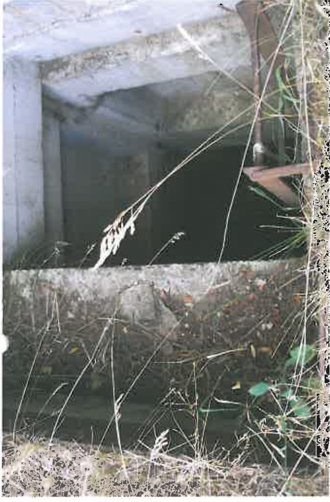
Foto 18: Fläche C: Schacht mit Einstiegsleiter an der nördlichen UG - Grenze
