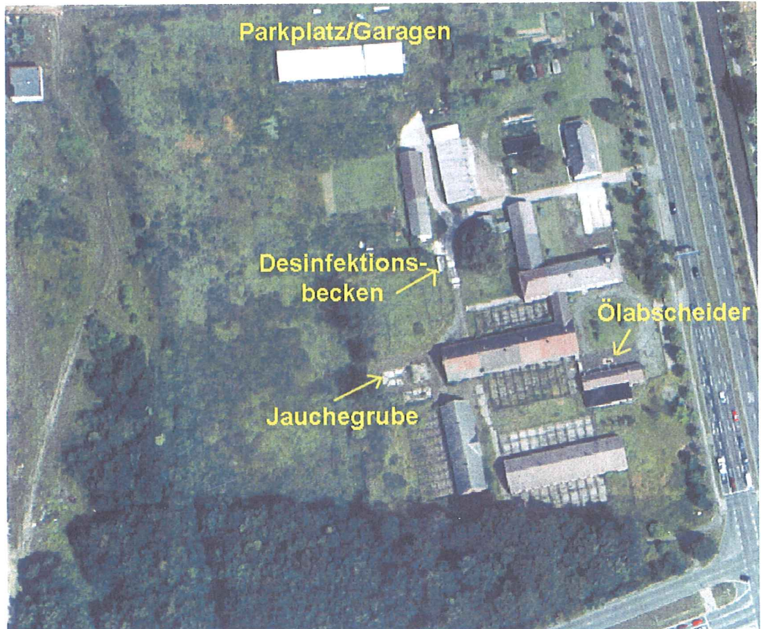
Abb. 1: Gebäudebestand der ehemaligen „Bullenstation“
